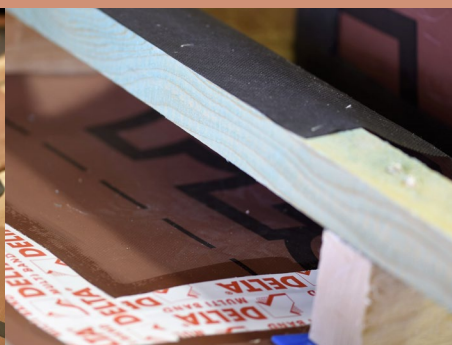
Vytvoření odvodňovacího žlábků
